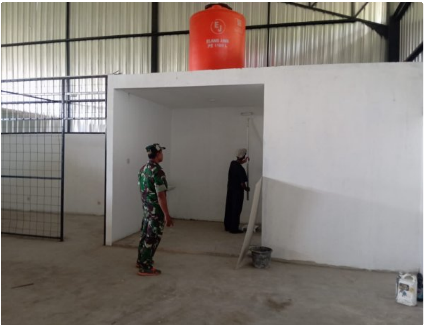
Babinsa Desa Nangsri Monitoring Pembangunan KDKMP, Pastikan Kualitas Dan Kelancaran Pekerjaan
