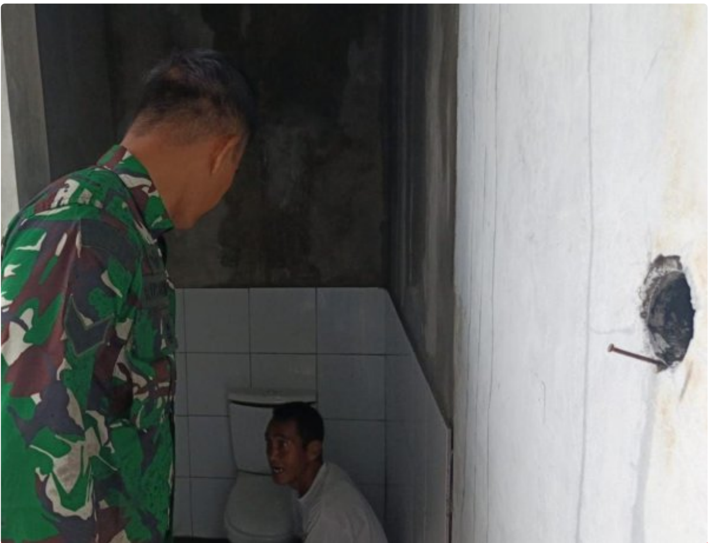
Babinsa Lakukan Monitoring, Pembangunan KDKMP Capai Tahap Pemasangan Kloset Dan Keramik
