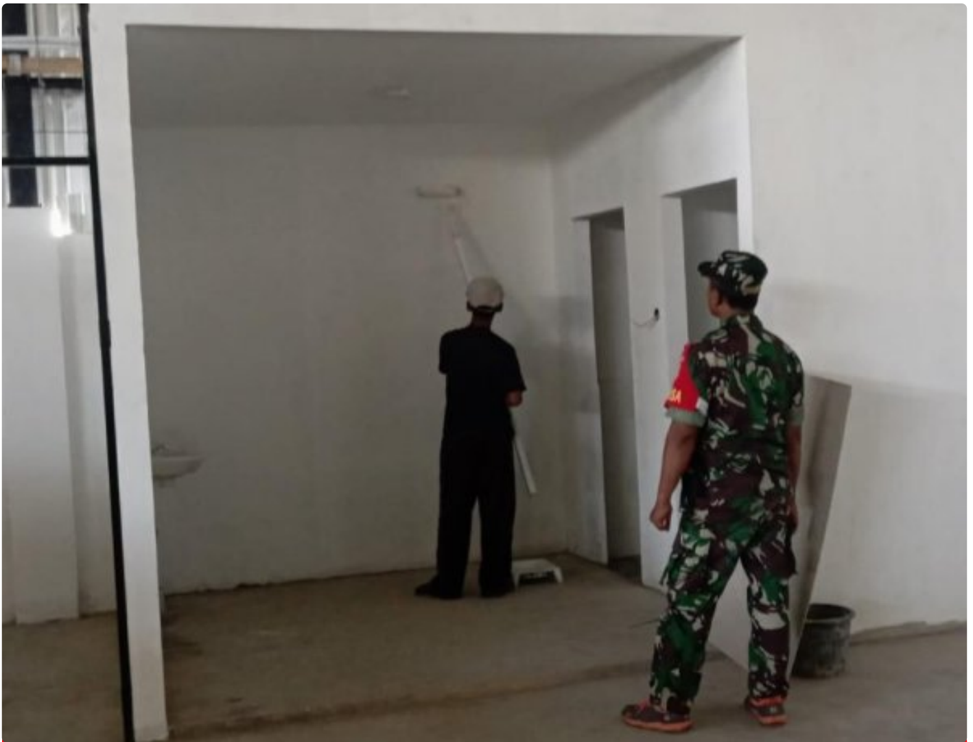
Babinsa Nangsri Pantau Pengecatan Gudang KDKMP
