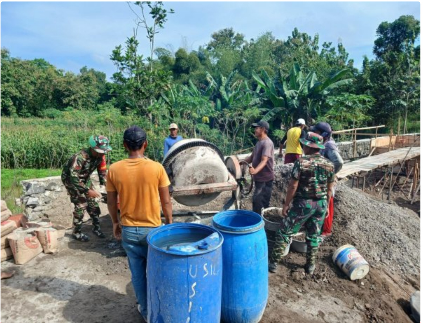
Gotong Royong Jadi Kunci Pembangunan Jembatan Garuda
