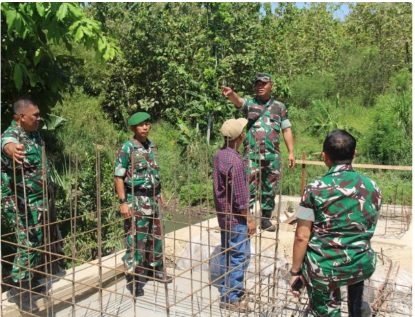
Pasiter Kodim Klaten Dampingi Danden Zibang Dan Kasiter Korem Tinjau Pembangunan Jembatan Garuda Di Klaten
