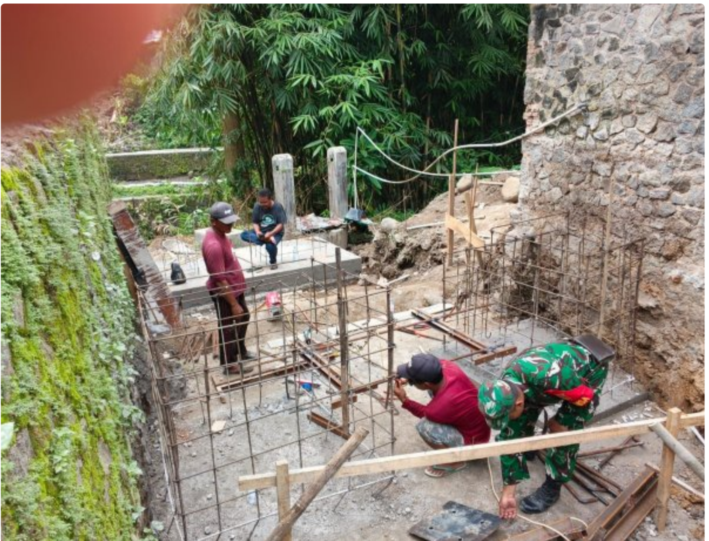
Pastikan Kualitas Konstruksi, Babinsa Dampingi Pengelasan Angkur Jembatan Garuda Di Desa Kranggan
