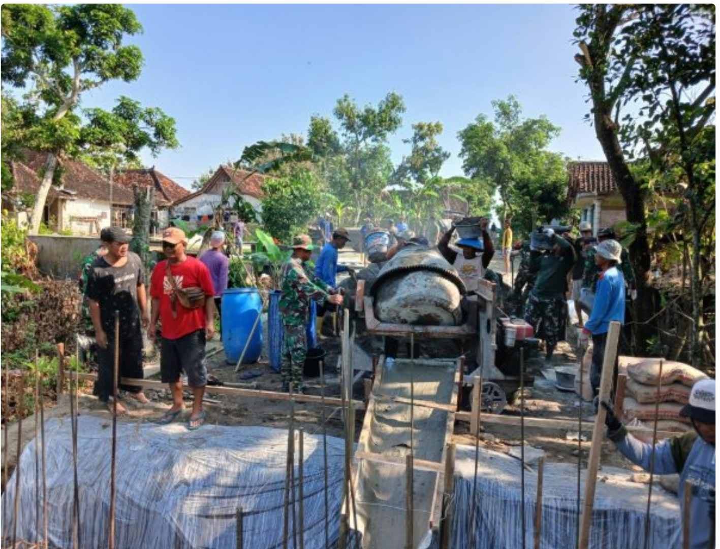
Pembangunan Jembatan Garuda Di Karangpaket, Kemanunggalan TNI Dengan Rakyat Sangat Terasa
