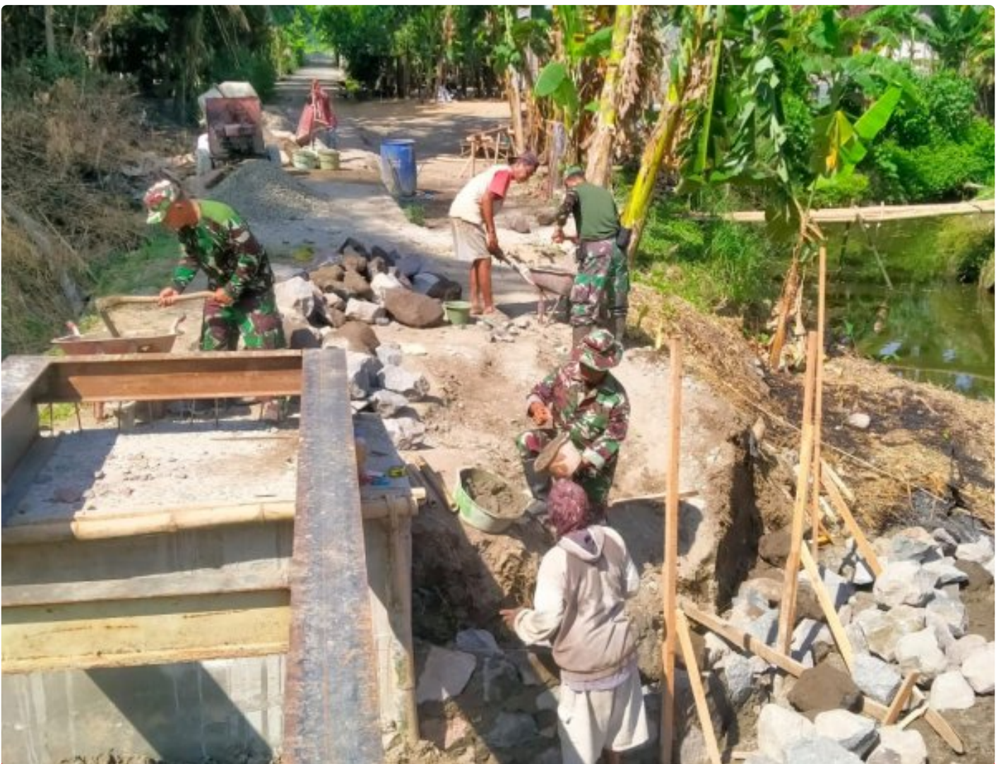
Tahap Struktur Dimulai, Jembatan Garuda Dibangun Dengan Semangat Kemanunggalan TNI-Rakyat
